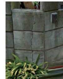
2019年6月 ブロックの亀裂の成長
